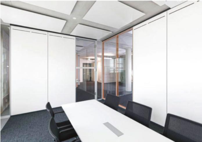
*/ Da wegen der betonkerntemperierten Decke keine Abhangdecke zur Luftführung zur Verfügung steht, sorgen integrierte Überströmelemente für die Durchlüftung.*
