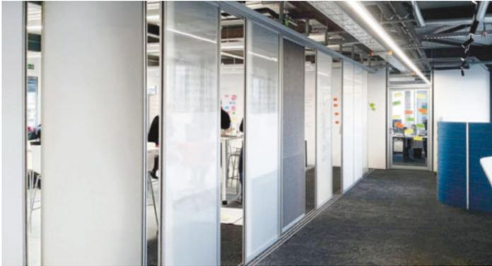
*Raumteiler-Schiebetüren sind gerade in offenen Bürostrukturen eine ideale Möglichkeit, um Räume bei Bedarf abzutrennen oder zu öffnen.*
