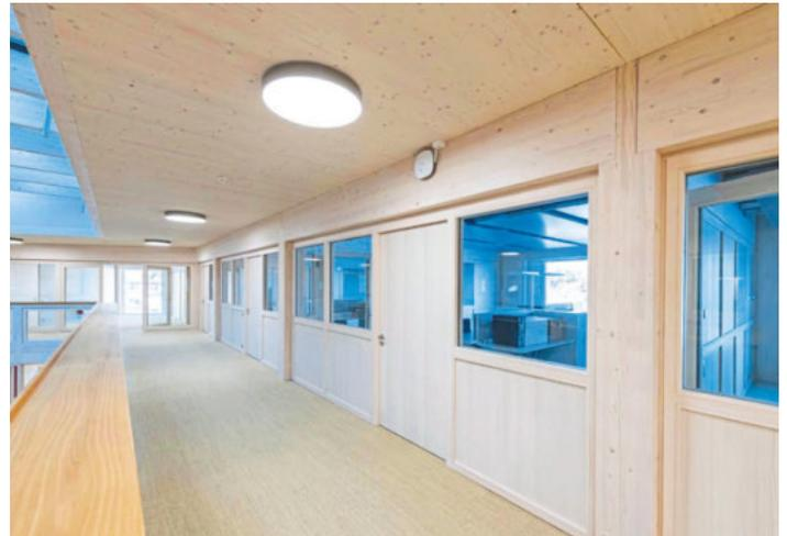
*/ Die nichttragenden Trennwände zu den Atrien sind aus zugelassenen Hoba-Brandschutzverglasungen mit eingebauten Brandschutzgläsern und Holzpaneelfeldern.*
