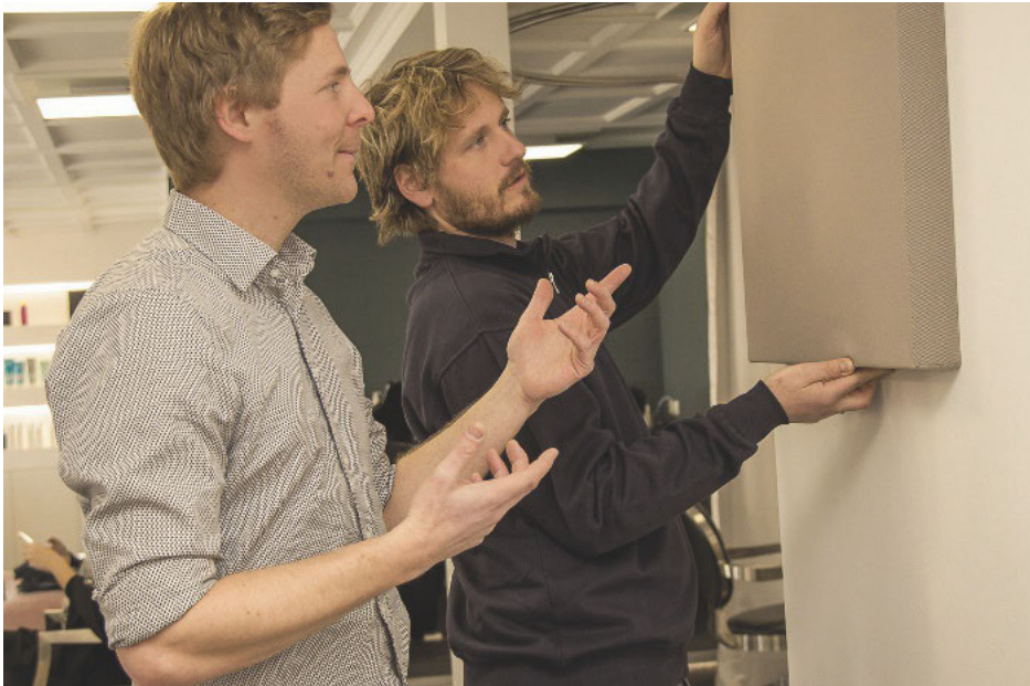
/ Verbessernde Maßnahmen: Michael Fuchs (l.) und Simon Holzer bei der Platzierung eines Absorbers in einem Objekt (Friseursalon Max in Wallersdorf).
